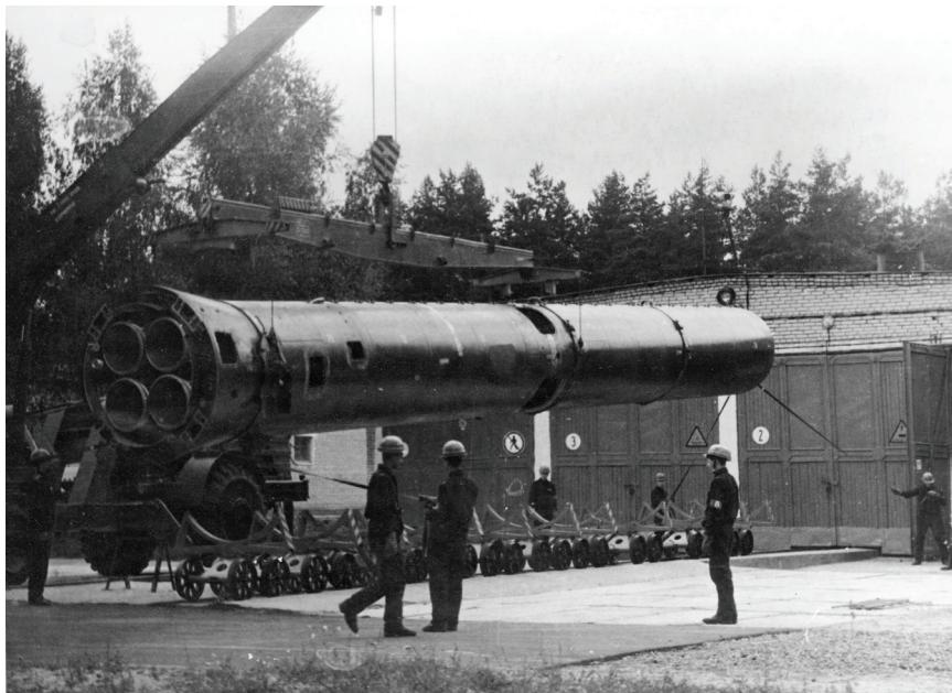
Перегрузка ракеты на технологическую тележку перед цехом резки.
